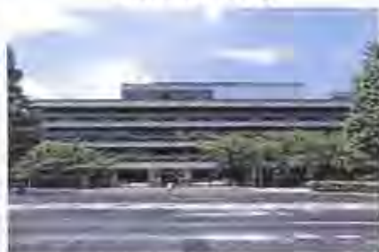
東京本館 建設準備
